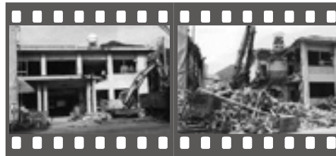
▲平成 14 年 7 月本館解体工事の様子
